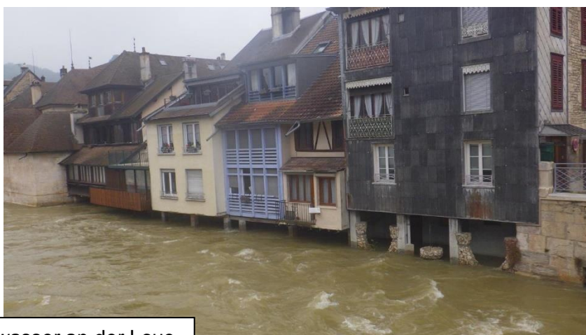
Hochwasser an der Loue
