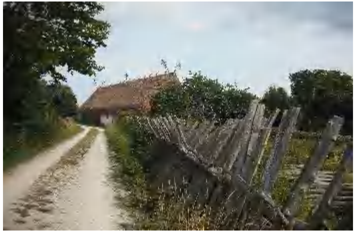
diese Zäune werden komplett ohne Nägel und Draht aufgebaut
